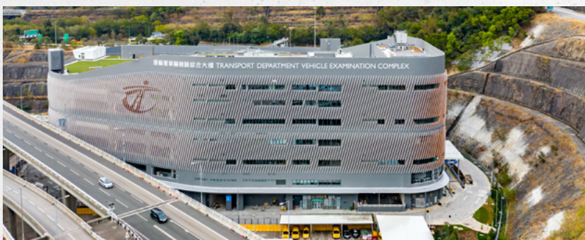
運輸署車輛檢驗綜合大樓
