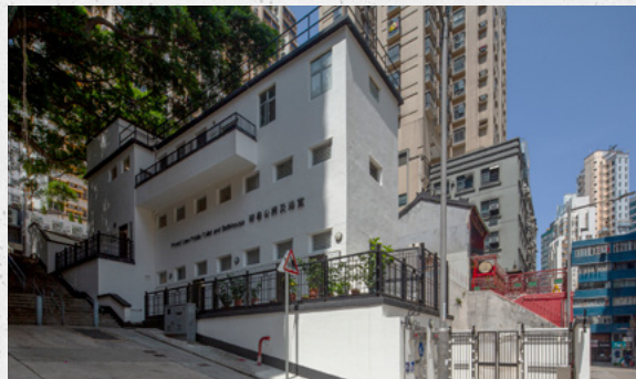
磅巷公廁及浴室翻修工程 復修 / 活化團隊獎 - 優勝獎
