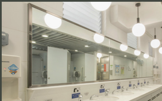
使用玻璃百葉窗既可捕捉自然光線，又可通風並減少能源使用量
