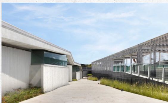
龙尾泳滩公共浴堂 城市介入项目 - 大奖
