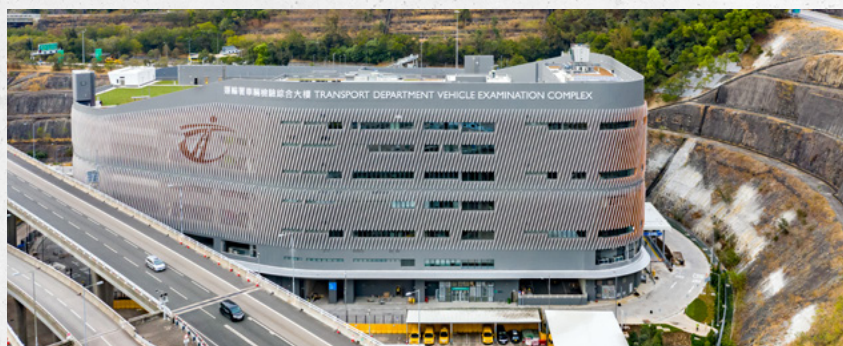
运输署车辆检验综合大楼
