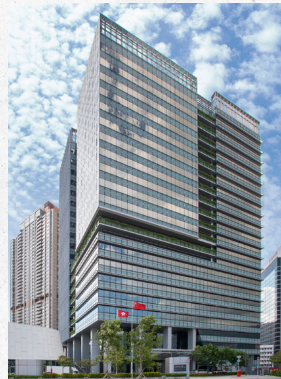
工业贸易大楼
