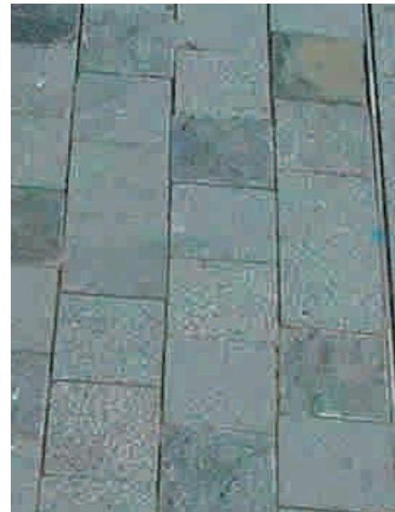
3.1.1c) Uneven surface
