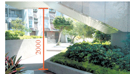
6.7.1j) 使用植物盆栽，防止行人在樓梯底淨空高度少於2000毫米的部份行走
