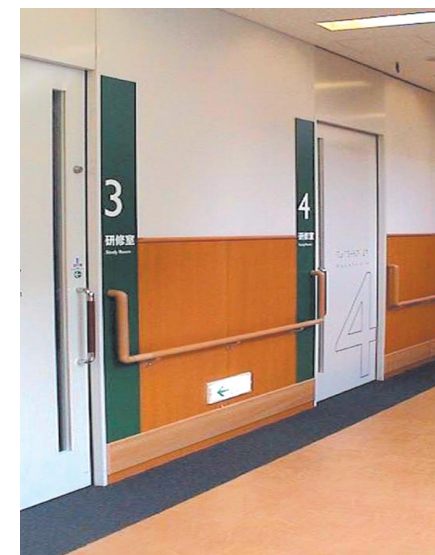
6.1.4c) 安裝在低位的出口指示標誌
