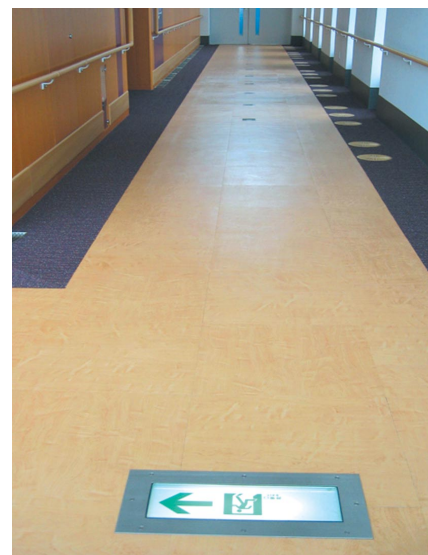
6.1.4b) 安裝在地面上的出口指示標誌
