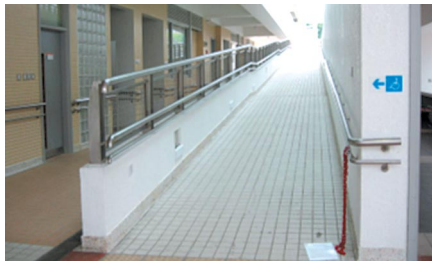
6.7.1 a) 採用斜道作上落樓層的途徑
