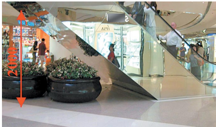
6.5.1 a) 在行人自動電梯底淨空高度低的地方放置盆栽作為補救措施
