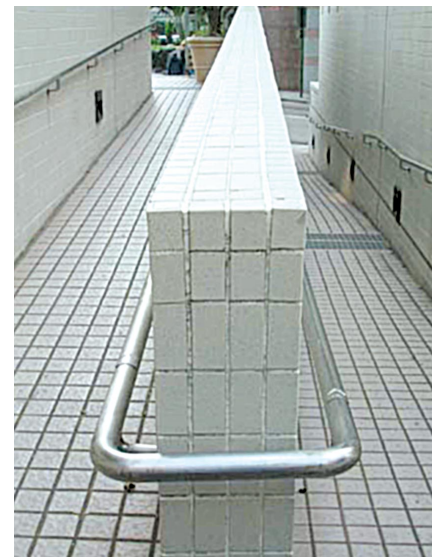
6.2.3c) 斜道上凹入牆身的照明裝置，扶手上鋪有凸字，提供方向指示
