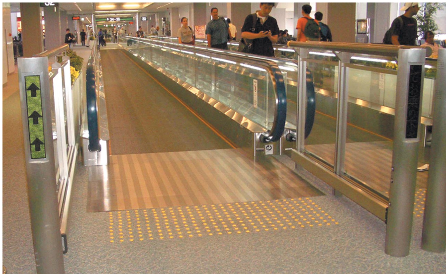
6.7.3a) 安裝觸覺警告帶及標誌指示行走方向，自動行人道的表面應與地面齊平
