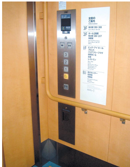
6.6.1 d) 在升降機內提供設施的資訊
