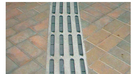
6.9.2a) 防滑堅固的憑觸覺使用的地面
