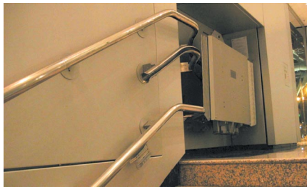
6.7.1e) X 不應使用在新建樓宇 O 如無另一條暢通易達的路徑時，可在小型的改善工程中使用
