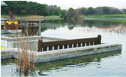
6.4.3f) 提升水面高度以便坐輪椅人士近距離接觸
