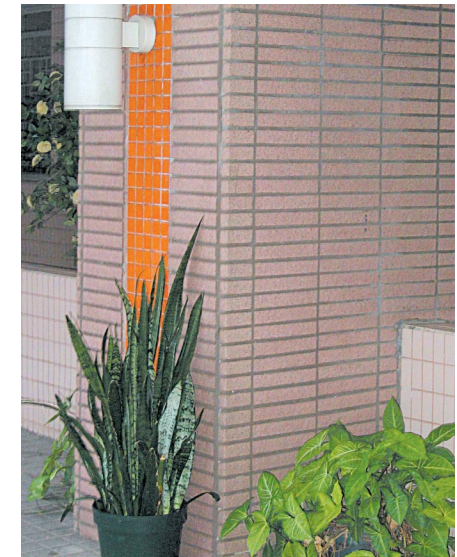
3.1.1 d) 突出的照明燈飾阻礙通道，補救措施是在其下放置盆栽
