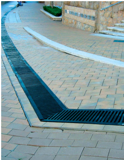
3.1.1 a) 起伏的行人道、高度不均的梯級都構成障礙和危險
